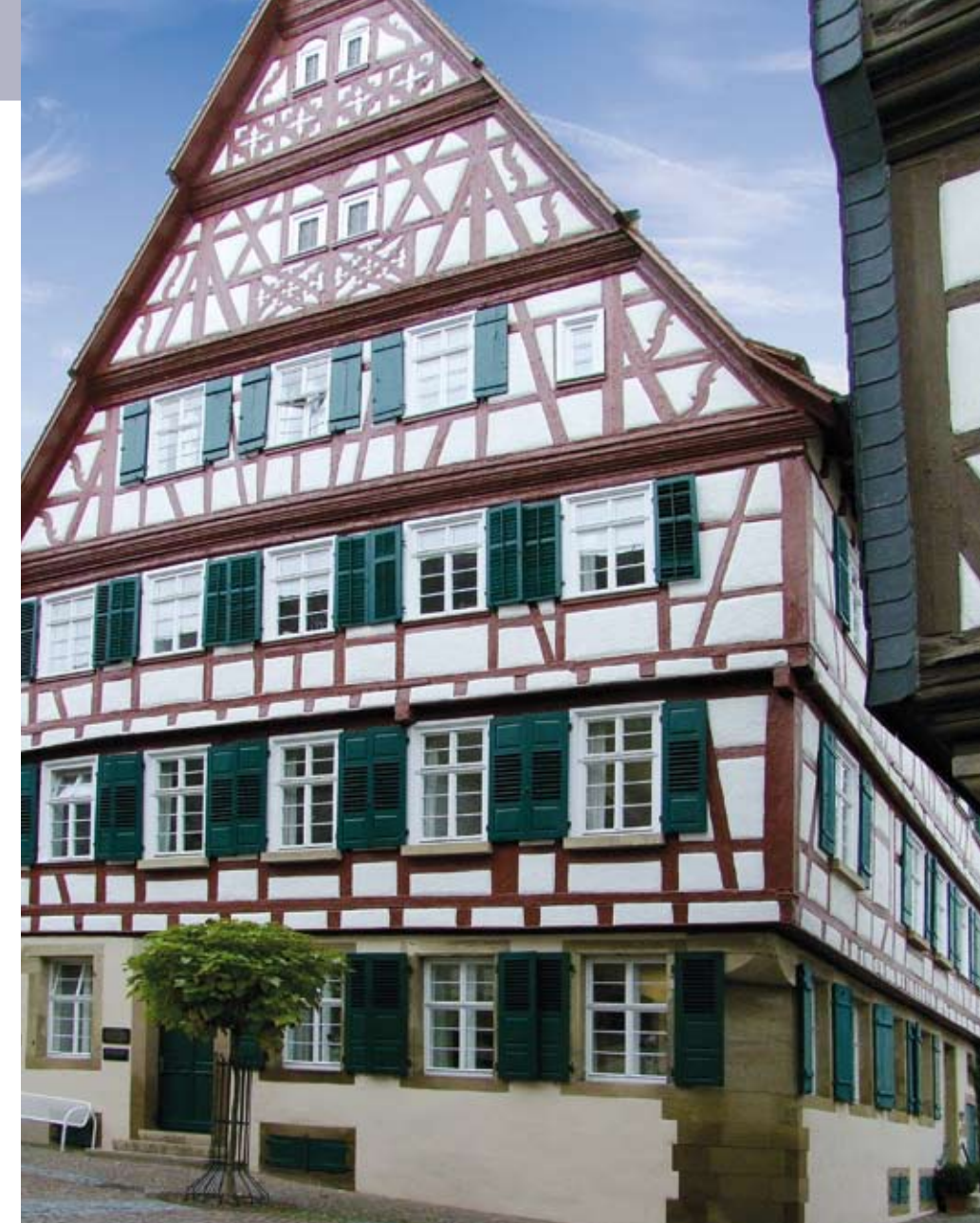
Die Kanzleiräume in der Kirchstraße im Zentrum von Brackenheim
